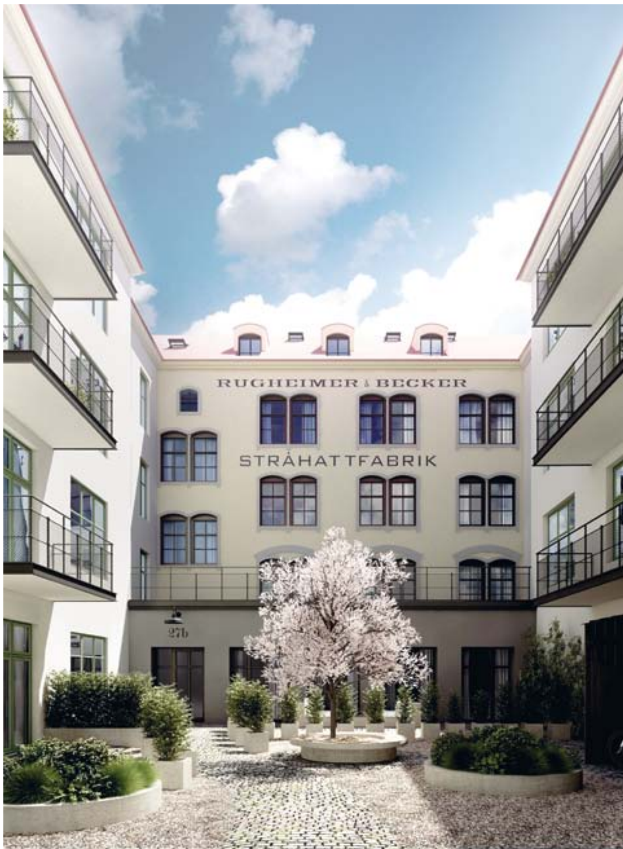
Stråhattfabriken, restaurerad fasad mot gård
